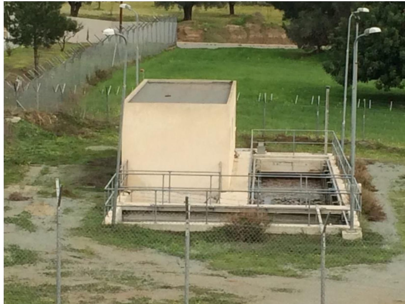
Σταθμός Επεξεργασίας Λυμάτων
